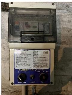
Position 0 le moteur est arrêté pour permettre de changer la position du sélecteur.
